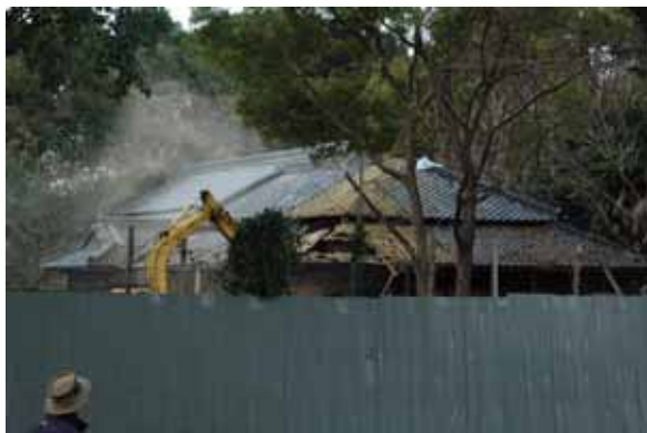
●主屋を重機で破壊(17日)
