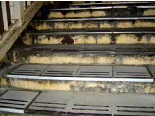
野崎駅線路を越えてわたる「跨線橋」の補修工事が行われました。
